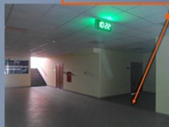
Переход (новый корпус)
